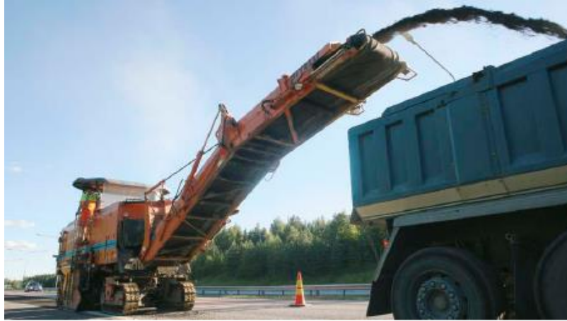
Ülesfreesitud materjali laadimine kallurile
